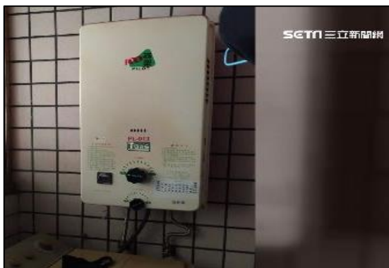
▲房東拒絕加裝熱水器排氣設備，房客未清理堆積陽台的雜物，都是導致一氧化碳中毒的原因。（示意圖／資料畫面，非本案現場）
