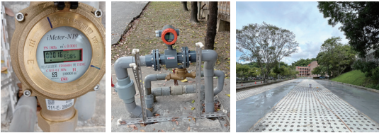
智慧水錶 (左/中) 與雨水儲留系統 (右)
