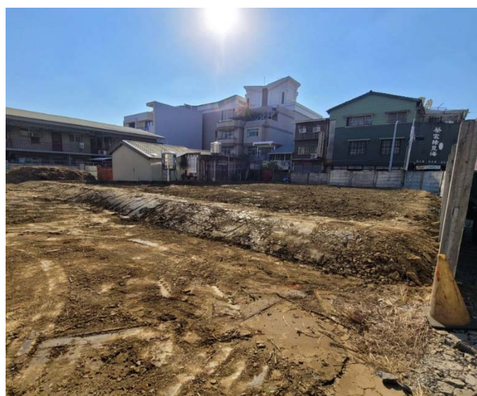
照片16：嘉義法院農園挖土機整地作業。
