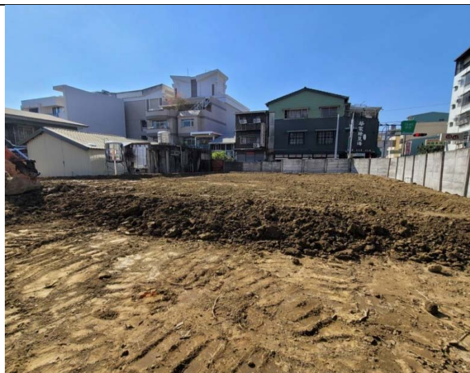
照片17：嘉義法院農園挖土機整地作業。
