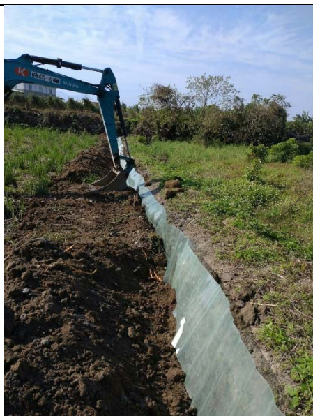
照片7：筴白筍田區、防漏水工程。
