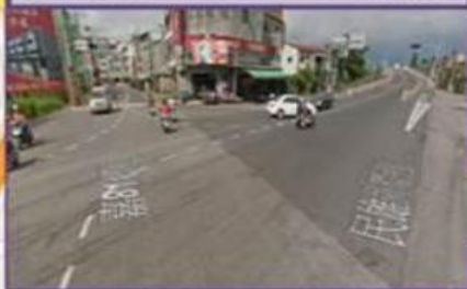
往民雄市區方向天橋
