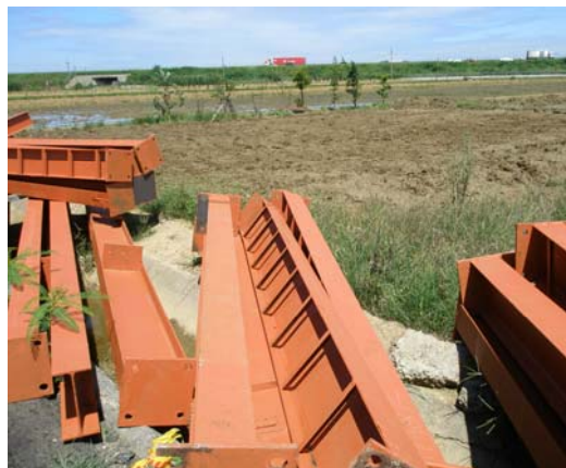
建築基地整地完成 屋舍結構鋼骨備妥 筆者拍攝（2009年6月20）
