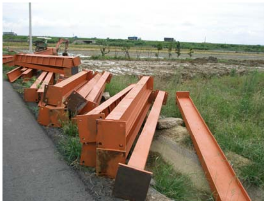
2009年6月19日 自台中運抵民雄的修復和裁切完整的舊有鋼骨
