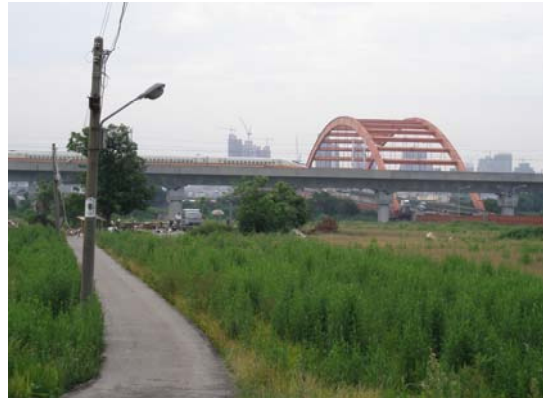
<拆除的鋼骨原地進行整修> 2009年6月16日 筆者拍攝（背景中高鐵班車正巧行駛而過）
